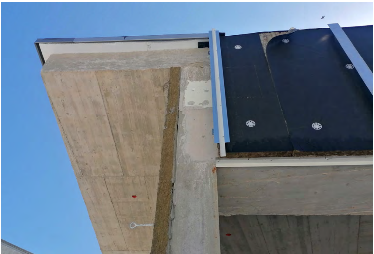
Zunanji avditorij SNG - sidrna plošča na fasadi, obstoječa.
