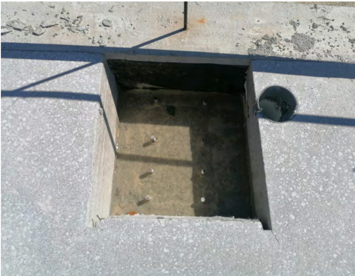
Zunanji avditorij SNG - sidrna plošča - temelj stebra, obstoječa.
