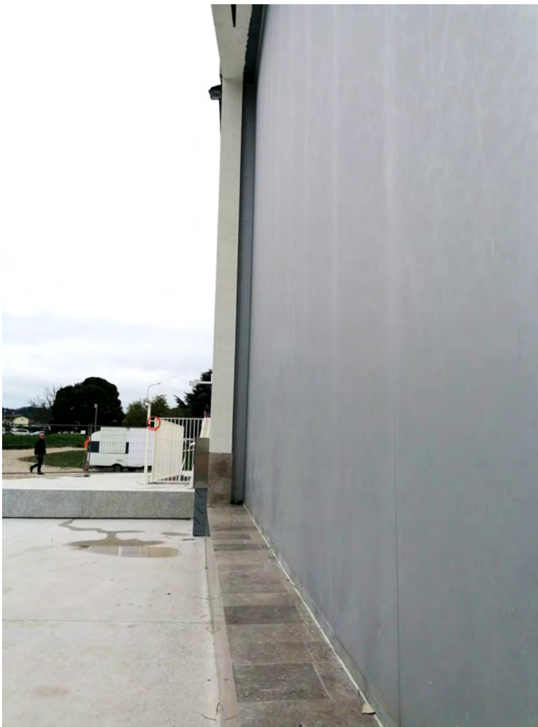
Zunanji avditorij SNG – obstoječa fasadna odprtina zaprta s fasadnimi ploščami.
