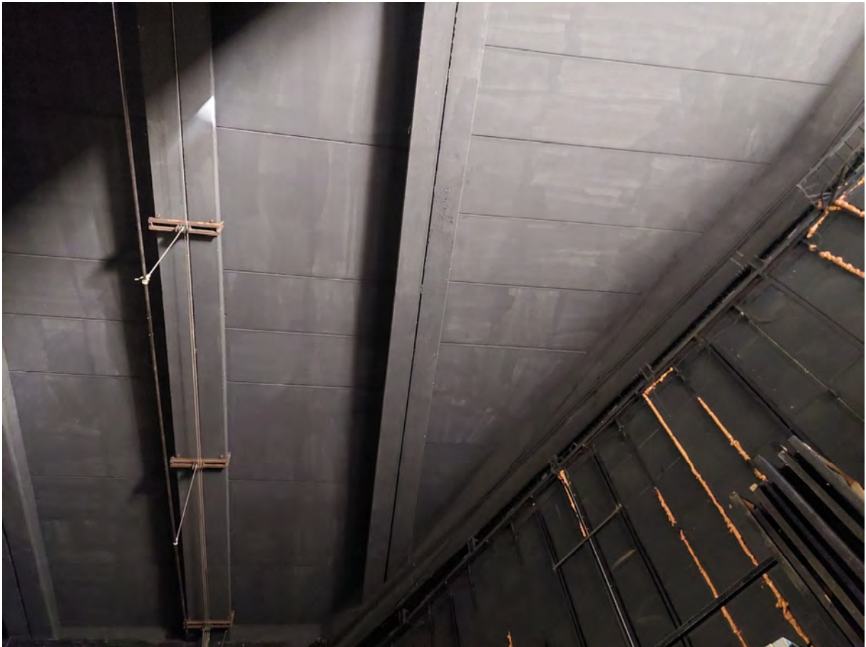
Zunanji avditorij SNG - strop v zaodrju, zablindirana obstoječa fasadna vrata z notranje strani.
